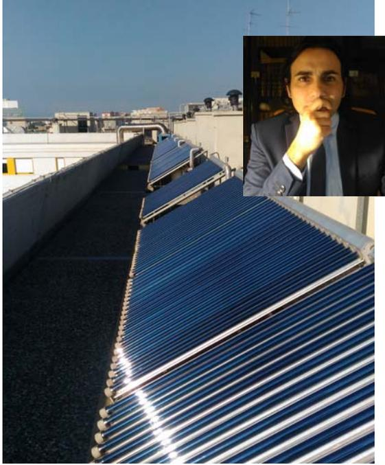
L'impianto, ubicato sul piano di copertura della clinica ed occupante una superficie di 112 mq, consente tramite uno scambiatore di calore a piastre, un elevato trasferimento termico di potenza e fornisce l'energia termica accumulata in n. 2 bollitori solari da 3000 litri ciascuno, per la produzione di acqua calda sanitaria.
