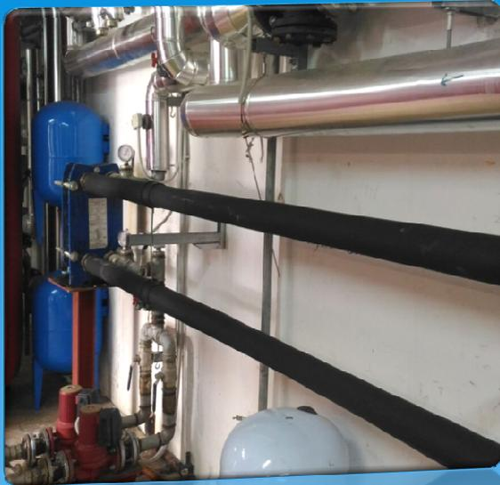
Dunque, anche se l'acqua calda viene erogata a temperature non inferiori ai 50°C, **nelle reti di ricircolo possono sussistere temperature in grado di favorire lo sviluppo della *legionella*.**
